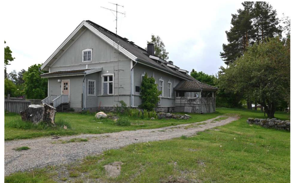
Kuva: Puustellin päärakennuksen pohjoispääty ja raitille avautuva pääfasadi.
