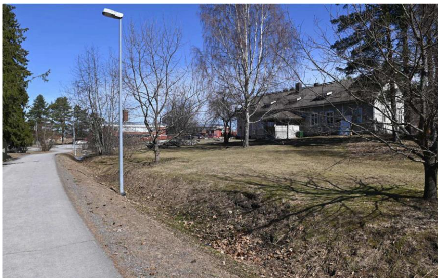
Kuva: Kevyen liikenteen väylä on rakennettu 2000-luvun alkuvuosina Brahentietä reunustavan kuusirivin itäpuolelle. Tienpuoleisella pitkällä sivulla on säilynyt vanha kuistimalli eli monilappeinen avokuisti.
